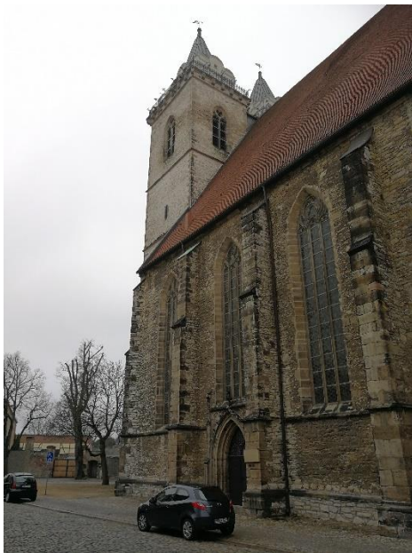
Blick auf die Johanniskirche vom Bürgerbüro
